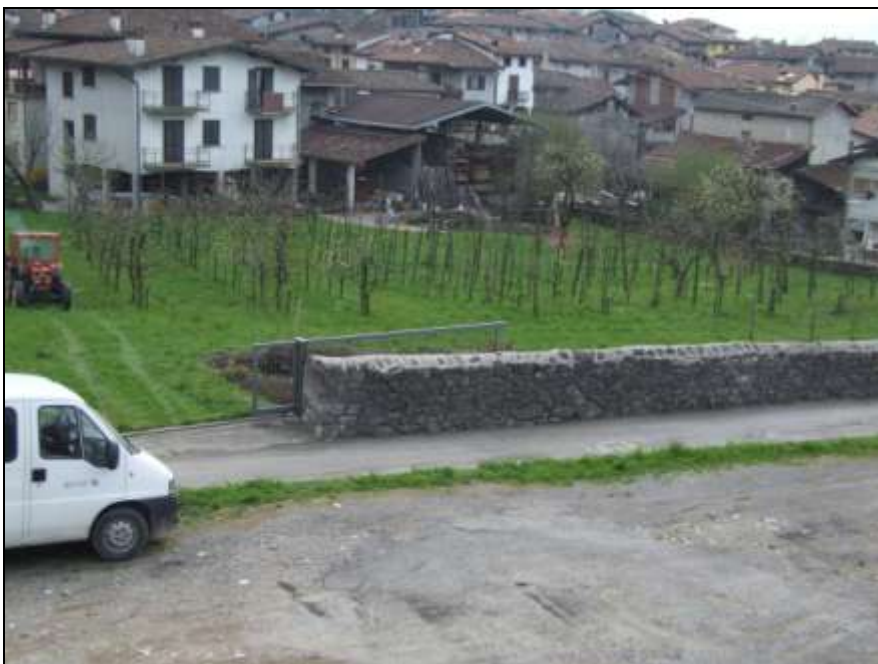
vista da via argine
