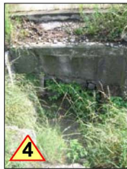
N. 3-4-5-PERICOLO NELLA FRUIBILITA' DELLA PISTA CICLOPEDONALE ESISTENTE PER LA PRESENZA DI FOSSI DI SCOLO DELLE ACQUE NON COPERTI
