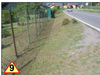
N. 9-PERICOLO AL MARGINE DELLA CARREGGIATA STRADALE PER LA PRESENZA DI FOSSO DI SCOLO DELLE ACQUE NON ADEGUATAMENTE PROTETTO
