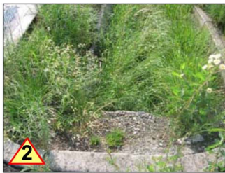
N. 2-PERICOLO NELLA FRUIBILITA' DELLA PISTA CICLOPEDONALE ESISTENTE PER LA PRESENZA DI FOSSO DI SCOLO DELLE ACQUE NON COPERTO
