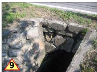
N. 9-PERICOLO AL MARGINE DELLA CARREGGIATA STRADALE PER LA PRESENZA DI FOSSO DI SCOLO DELLE ACQUE NON ADEGUATAMENTE PROTETTO
