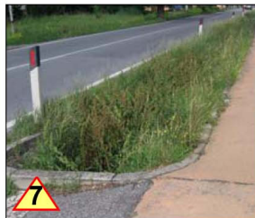
N. 7-8-PERICOLO NELLA FRUIBILITA' DELLA PISTA CICLOPEDONALE ESISTENTE PER LA PRESENZA DI FOSSI DI SCOLO DELLE ACQUE NON COPERTI
