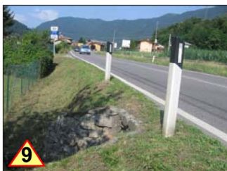
N. 9-PERICOLO AL MARGINE DELLA CARREGGIATA STRADALE PER LA PRESENZA DI FOSSO DI SCOLO DELLE ACQUE NON ADEGUATAMENTE PROTETTO
