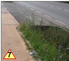
N. 7-8-PERICOLO NELLA FRUIBILITA' DELLA PISTA CICLOPEDONALE ESISTENTE PER LA PRESENZA DI FOSSI DI SCOLO DELLE ACQUE NON COPERTI
