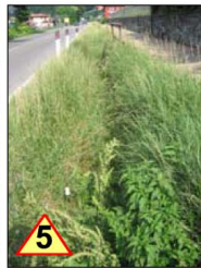
N. 3-4-5-PERICOLO NELLA FRUIBILITA' DELLA PISTA CICLOPEDONALE ESISTENTE PER LA PRESENZA DI FOSSI DI SCOLO DELLE ACQUE NON COPERTI
