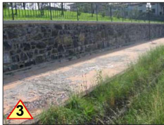
N. 3-4-5-PERICOLO NELLA FRUIBILITA' DELLA PISTA CICLOPEDONALE ESISTENTE PER LA PRESENZA DI FOSSI DI SCOLO DELLE ACQUE NON COPERTI
