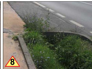
N. 7-8-PERICOLO NELLA FRUIBILITA' DELLA PISTA CICLOPEDONALE ESISTENTE PER LA PRESENZA DI FOSSI DI SCOLO DELLE ACQUE NON COPERTI
