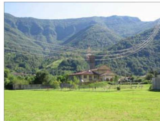
foto n.5 CHIESA DI S. REMIGIO E PARCO
