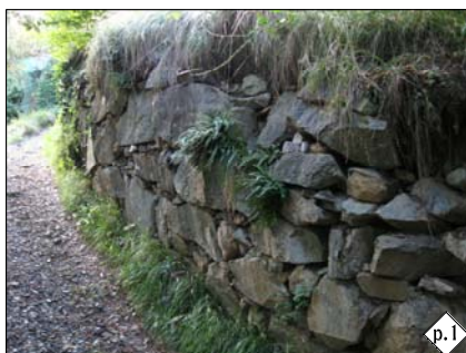
particolare muro a secco
