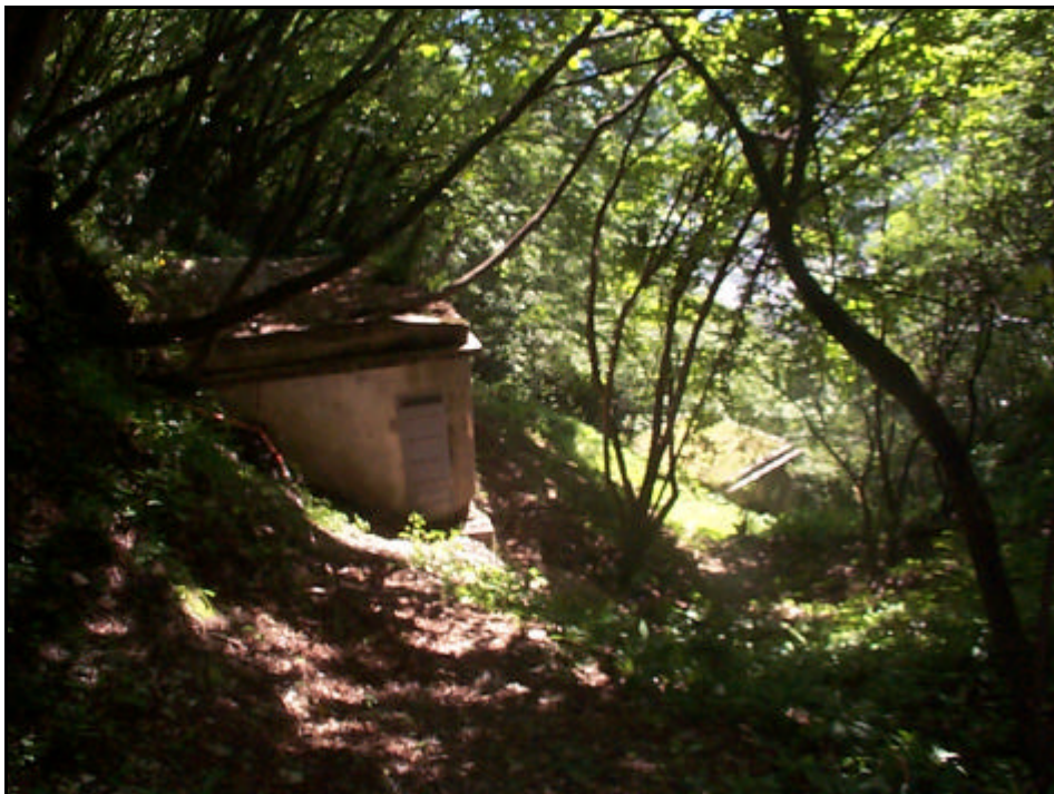
Foto n. 36 – Opere di presa della Sorgente Grione in località Valle delle Fontane
