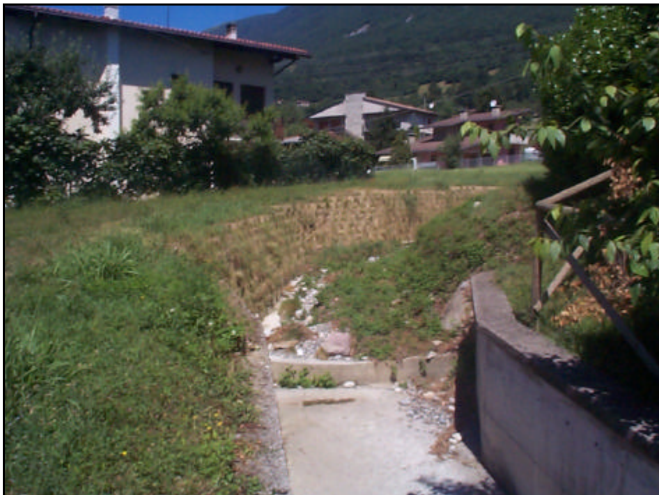
Foto n. 34 – Opera di difesa spondale in località Piangaiano
