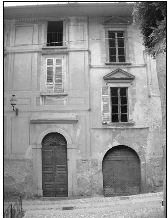
Foto 23 - Edificio, Via C. Battisti (2/A2)
