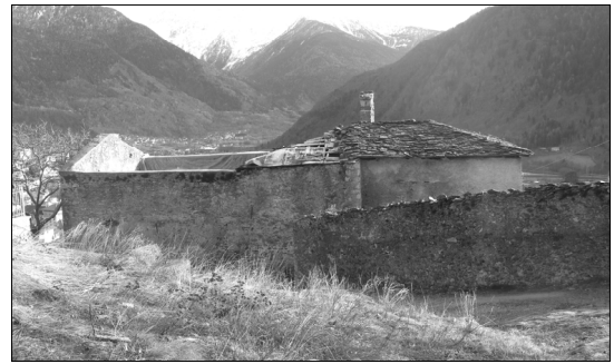
Foto 10 – Chiesa di S. Sebastiano (prima del restauro)
