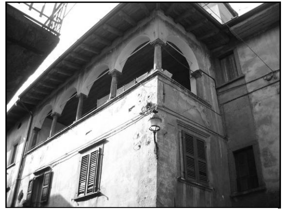
Foto 26 - Edificio n. 16-A2 in via C. Battisti
