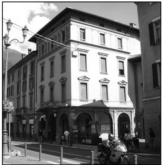
Foto 21 - Edificio, Via Porro (1/A4)
