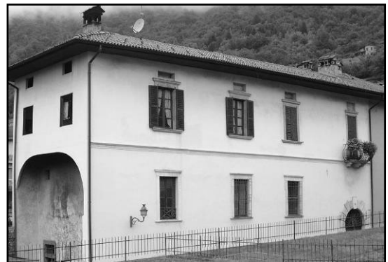
Foto 34 - Edificio, Via M. Grappa (14/A5)
