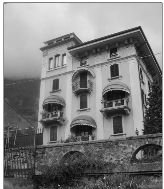
Foto 39 – Edificio in Via Porro
