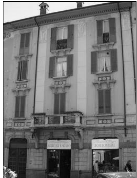
Foto 31 - Edificio, Via Porro (2/A4)
