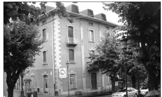
Foto 35 - Edificio, V.le Derna (55/A5)
