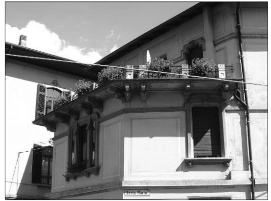
Foto 33 - Edificio, Via S. Maria (20/A4)
