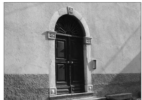
Foto 29 - Edificio, Via C.Battisti (24/A3)
