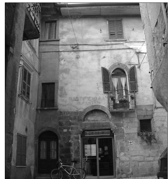
Foto 25 - Edificio, Via C. Battisti (14/A2)
