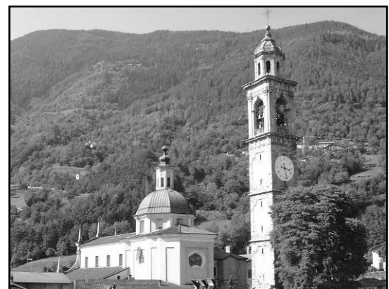
Foto 2 - Chiesa di S. Maria Nascente [1-3/A7]
