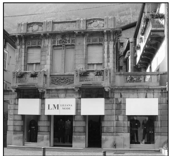
Foto 28 - Edificio, Via Porro (3/A3)
