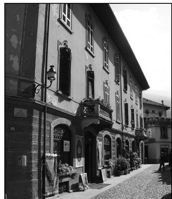
Foto 32 - Edificio, Via Mottinelli (18/A4)
