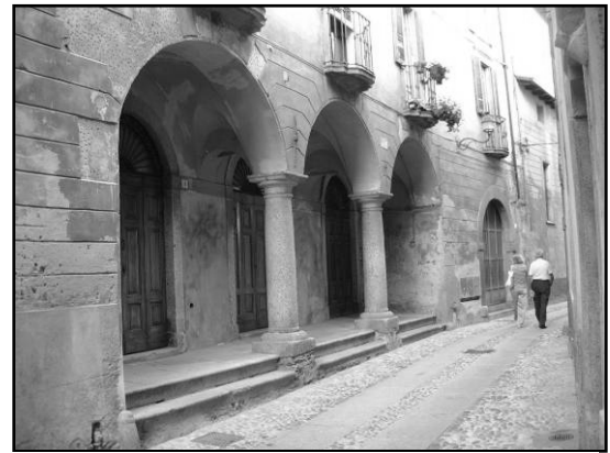
Foto 30 - Edificio, Via C. Battisti (39/A3)
