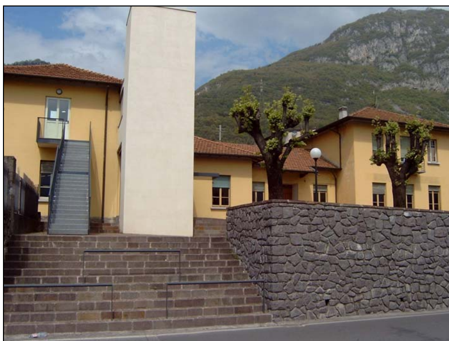
Corti alto – biblioteca auditorium
