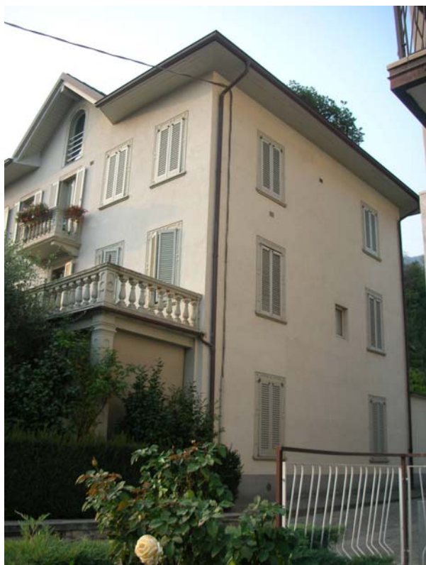
edificio n. E28 novembre 2008
