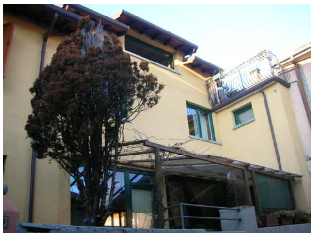
unità di rilevamento n.25 gennaio 2008
