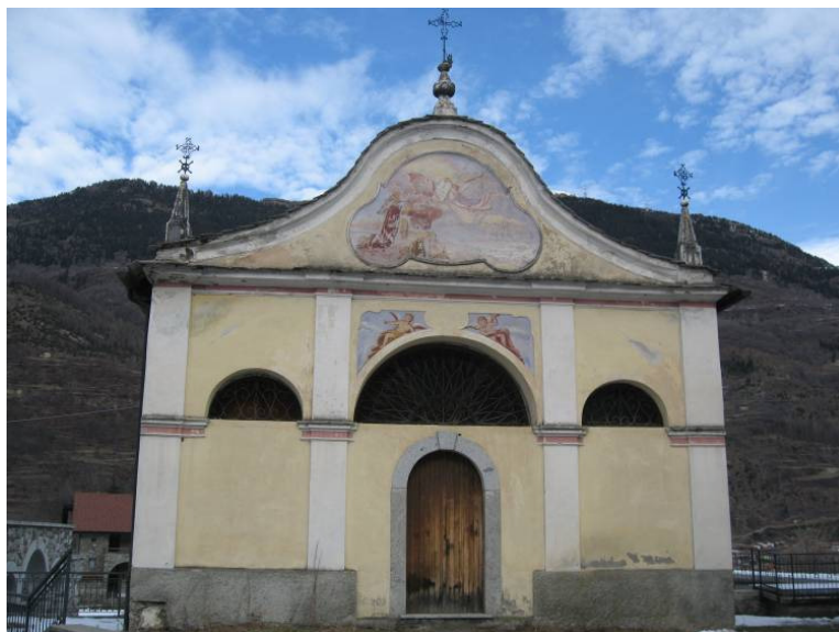
a) Cappella cimiteriale, nella frazione Santicolo
