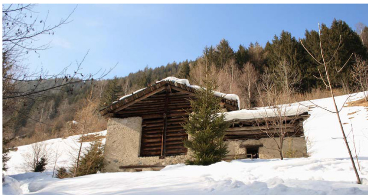
Fienile lungo il sentiero che da S. Antonio conduce a Campovecchio
