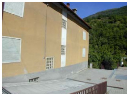
Unità di rilevamento 29 (rif. foto n.26)
