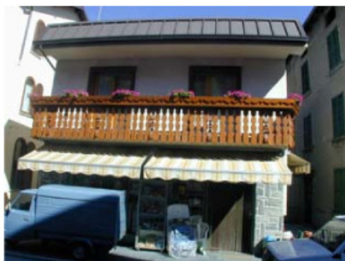
Unità di rilevamento 31 (rif. foto n..27)
