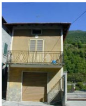
Unità di rilevamento 29 (rif. foto n.25)
