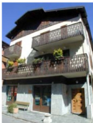
Unità di rilevamento 32 (rif. foto n.29)
