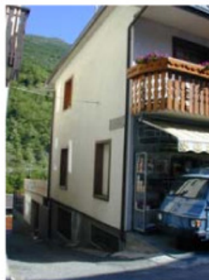
Unità di rilevamento 31 (rif. foto n.28)
