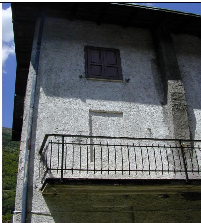
**AP.2 – Integrazione muratura storica con tamponamento in mattoni e/o blocchi, aggiunta di pilastri****Murature**
