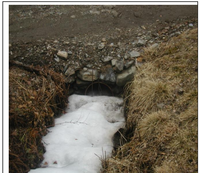
Foto 5 Sezione di monte dell'attraversamento
