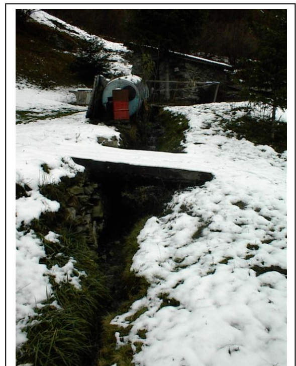
Foto 4. Vista del ponte da valle
