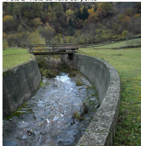
Foto 2 Vista da valle del ponte
