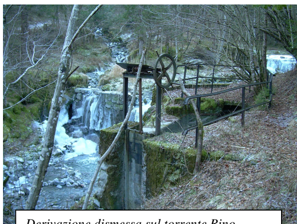
Derivazione dismessa sul torrente Rino
