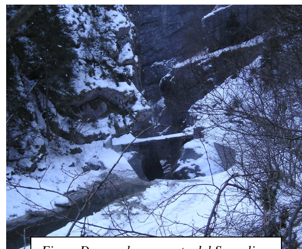
Fiume Dezzo: sbarramento del Saccolino
