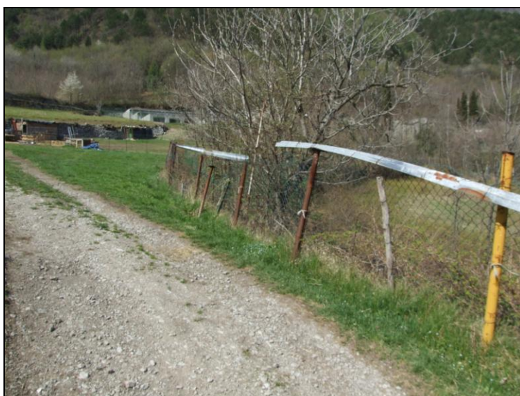
vista da valle verso monte
