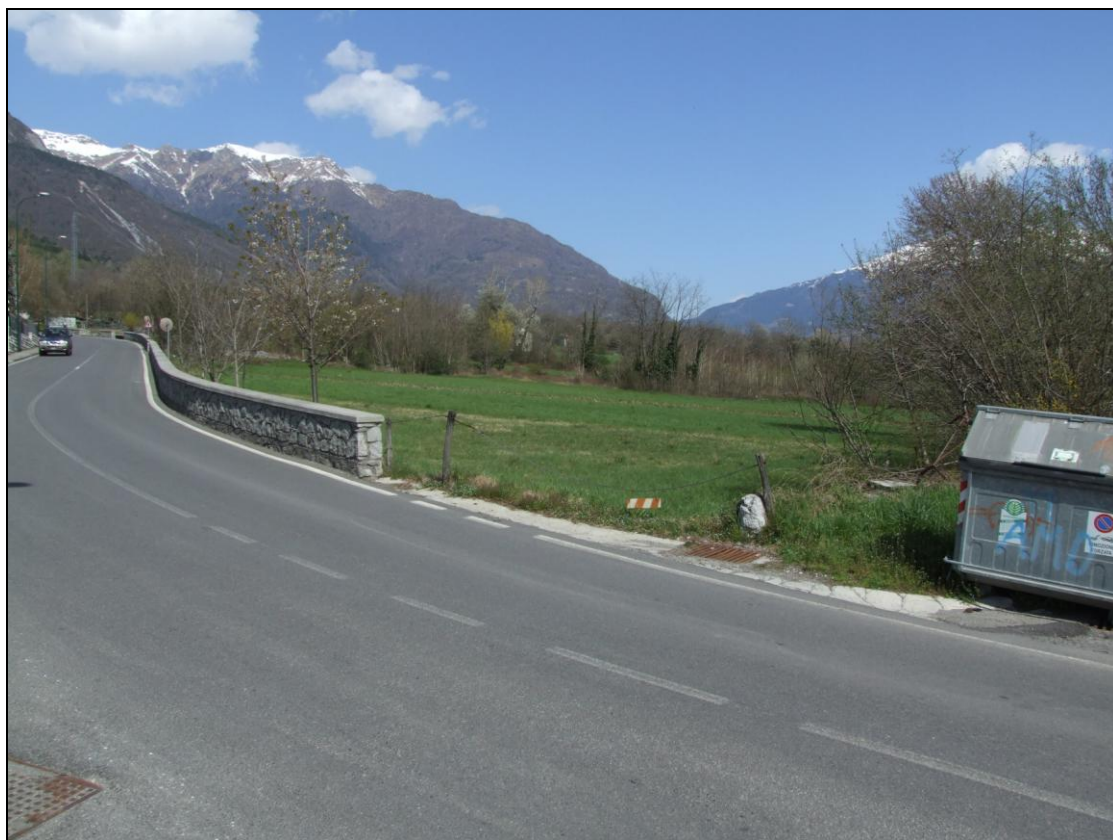
vista da via al ponte verso monte
