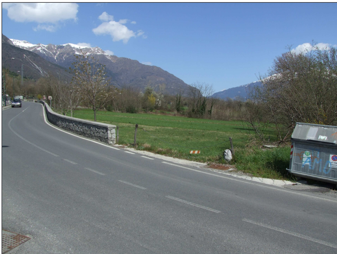
vista da via al ponte verso monte
