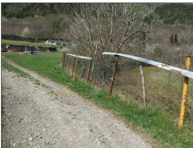
vista da valle verso monte
