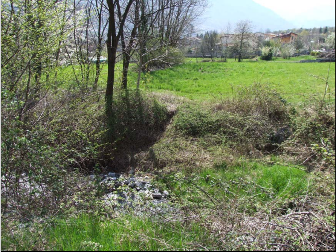
vista da argine torrente re
