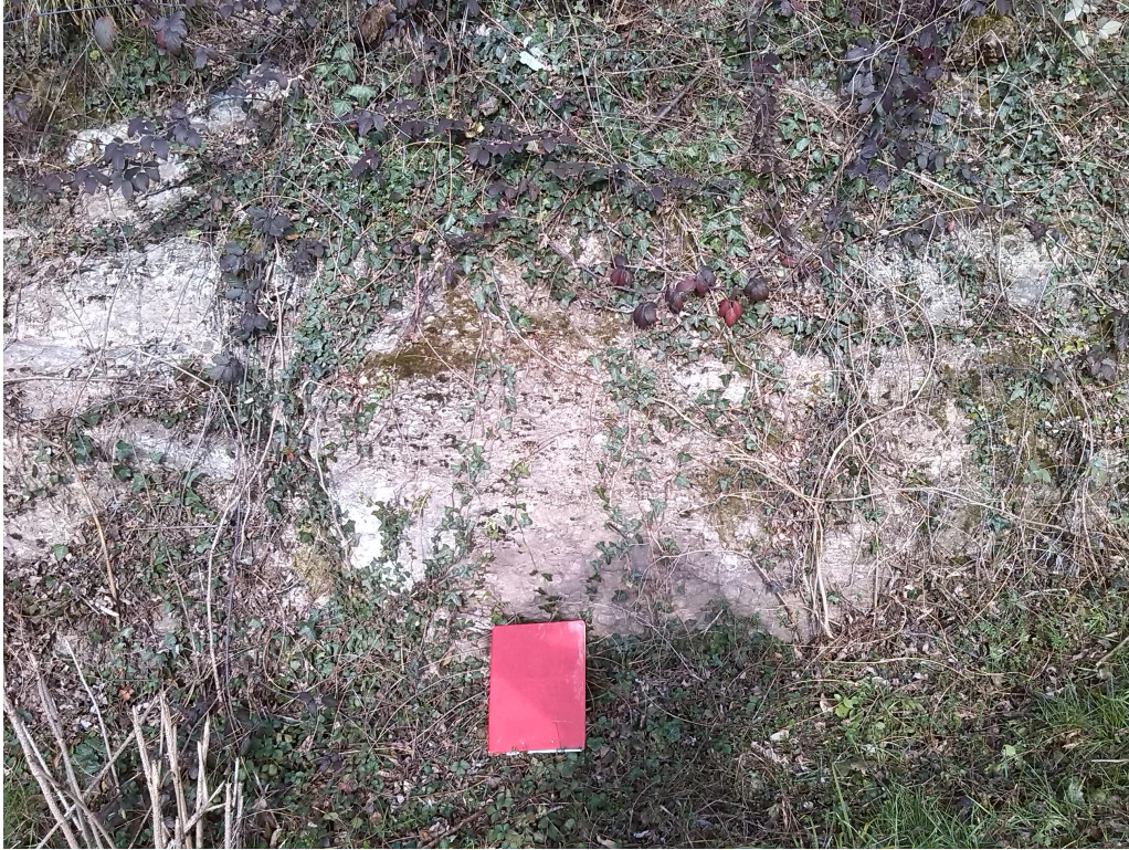
Figura 5-Dettaglio affioramento ammasso roccioso alla base della scarpata
