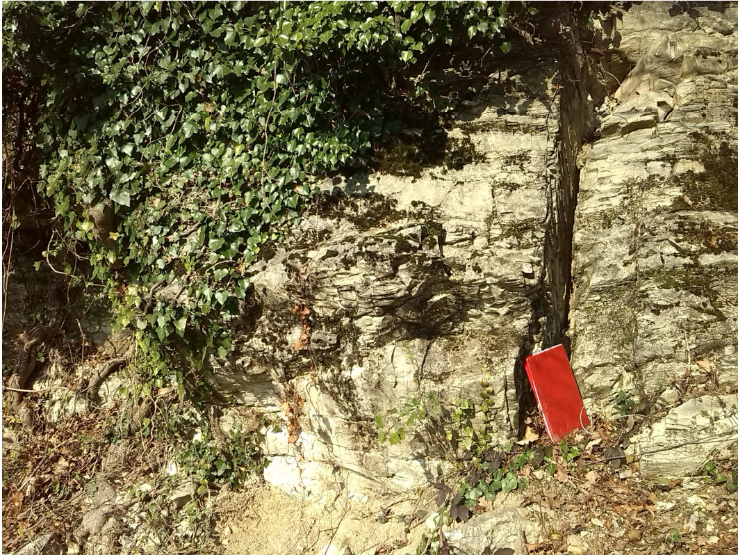
Figura 8 - Scarpata in roccia con blocco di dimensioni metriche in precarie condizioni di equilibrio
