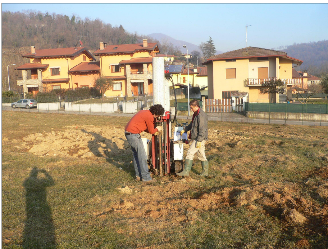
Figura 10: Esecuzione prove penetrometriche
