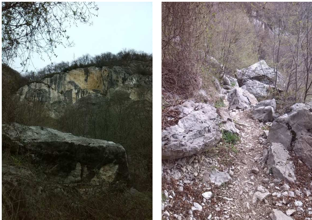
Figura 7- Frana della Corna rossa: superficie di distacco principale e accumulo di blocchi lungo il sentiero.
