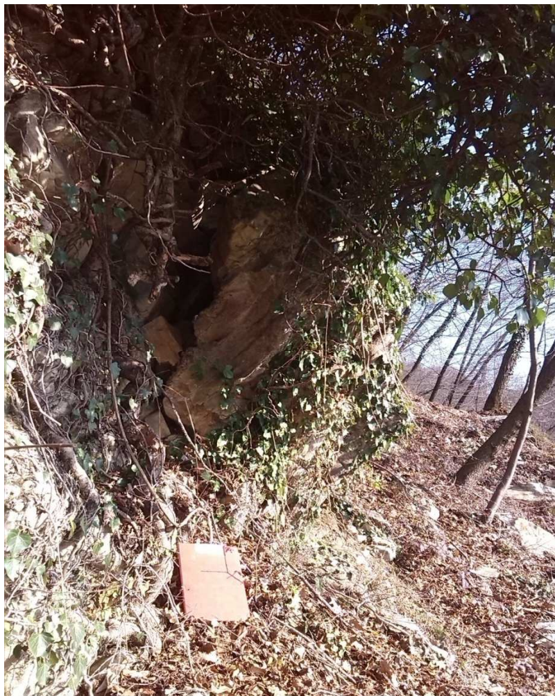
Figura 37- Dettaglio della scarpata nel settore più occidentale con volumi rocciosi mobilizzati in precarie condizioni di equilibrio
