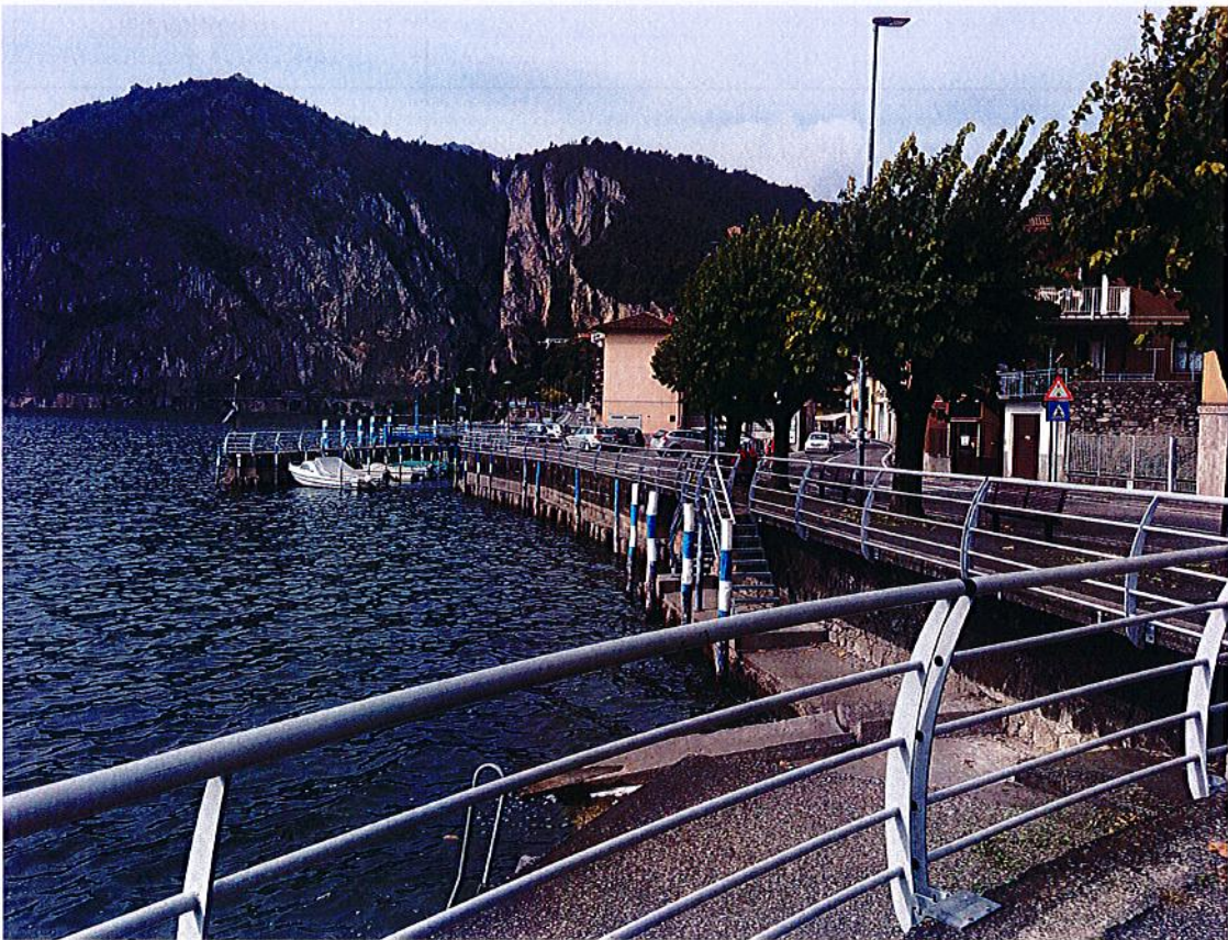
Veduta da Est in direzione opposta dalla rotonda di viale Roma
