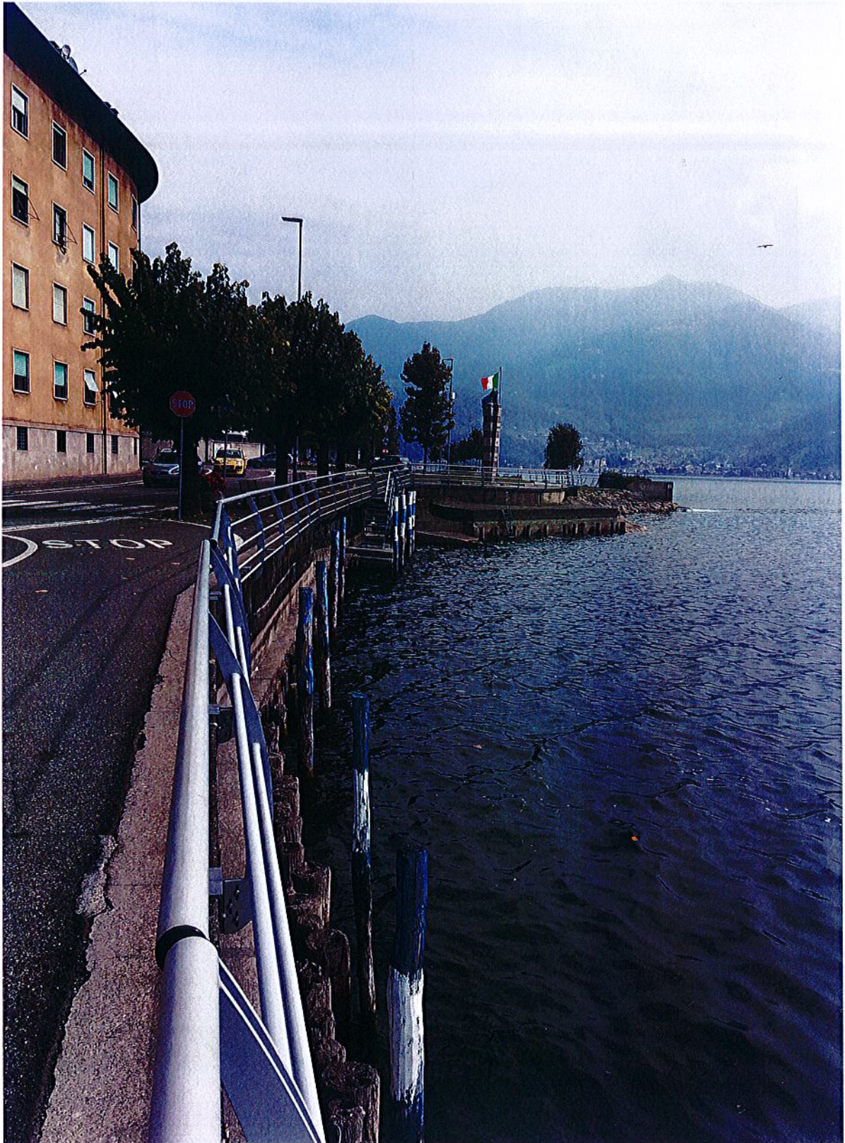
L'attuale lungolago, caratterizzato da un percorso promiscuo, carrabile e pedonale
