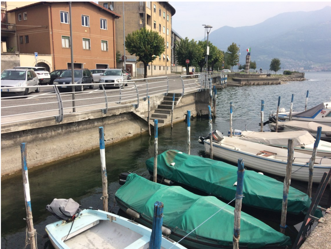
Il secondo tratto di lungolago, procedendo verso Est: il piccolo porticciolo
