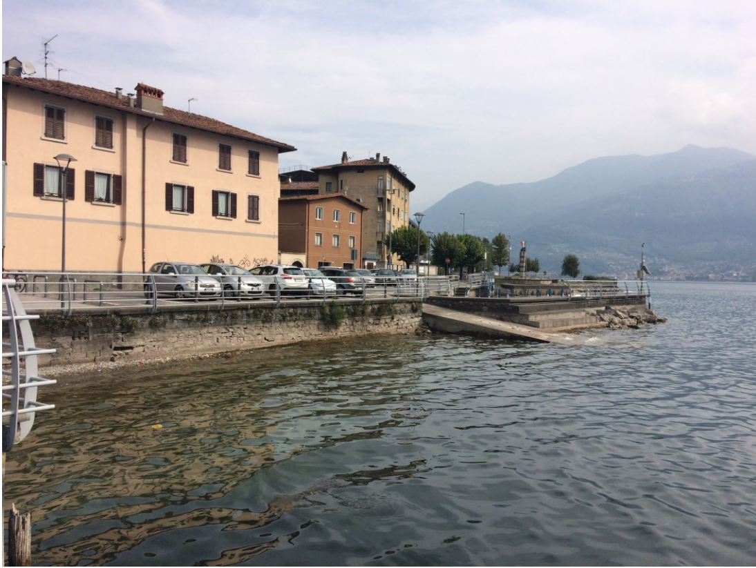
Sopra: il primo tratto di lungolago, di fronte all'edificio esistente, di proprietà demaniale
