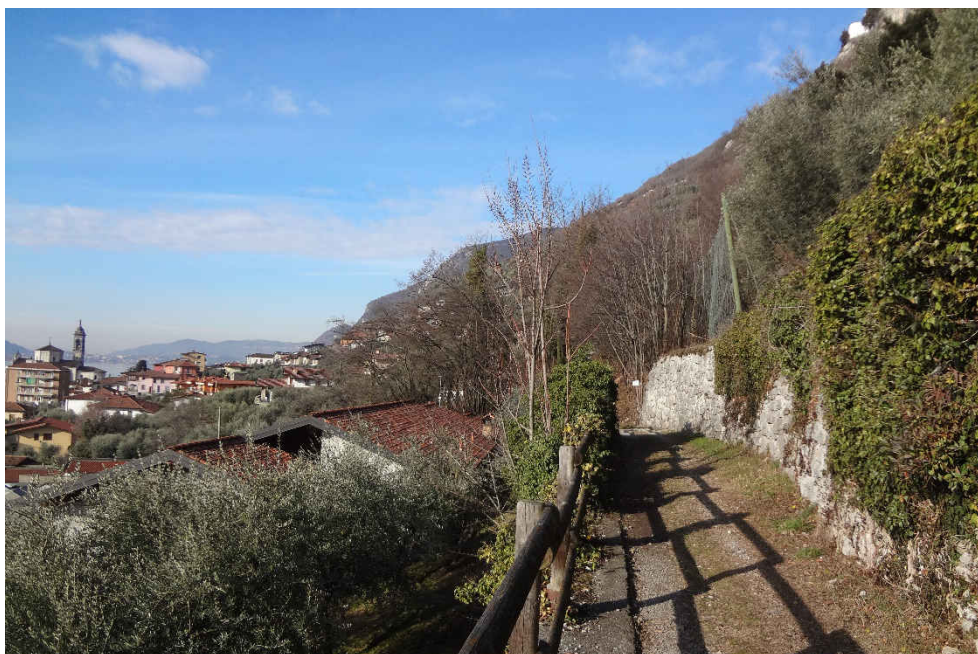
Figura 42 – Vista porzione area omogenea A dal sentiero, visibili la fila di valle delle reti paramassi e le abitazioni ubicate a quota 200 m s.l.m. circa.
