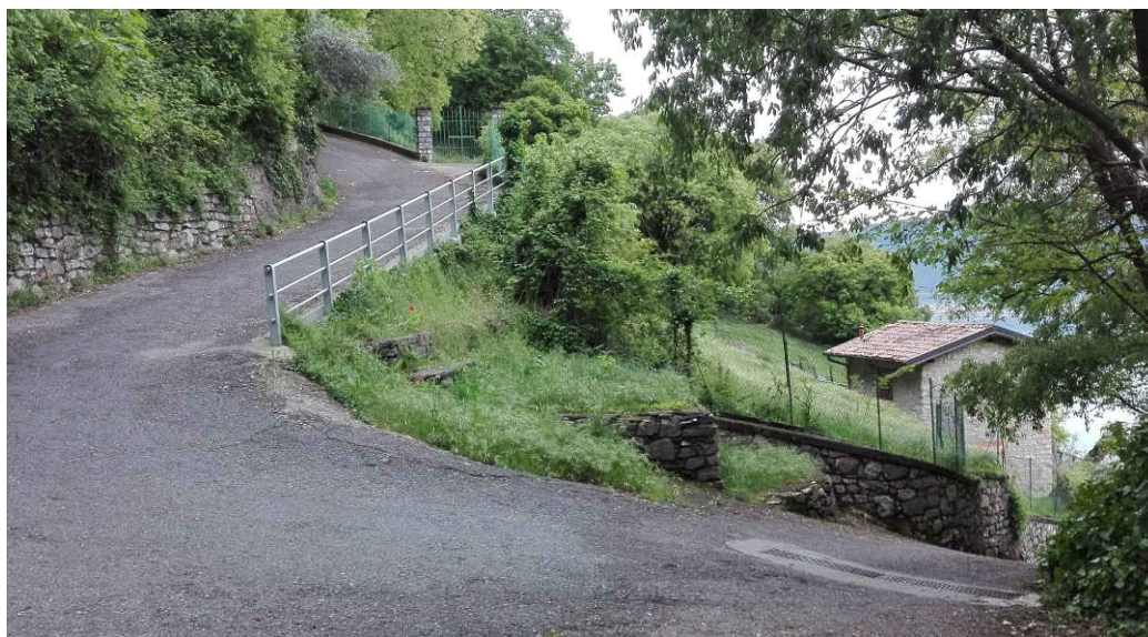
Figura 66 - Il fabbricato e la strada: l'area di studio si trova a monte e a valle del percorso stradale
