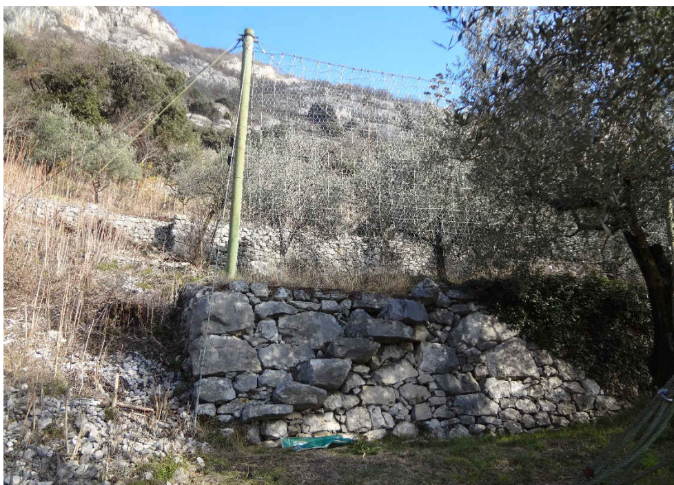
Figura 43 – Vista terrazzi antropici e reti paramassi presenti nell'area omogenea A, nell'area caratterizzata da presenza di uliveto.
