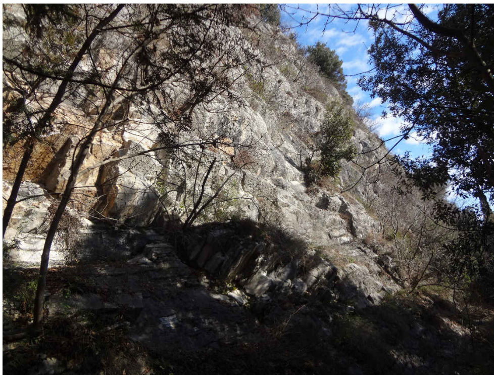
Figura 47 – Panoramica della parete subverticale presente nell'area omogenea C, da sentiero.
