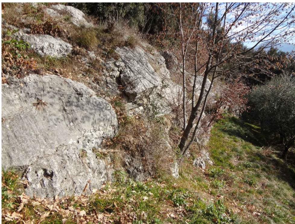
Figura 51 – Affioramento roccioso presente nell'area omogenea C a quota circa 280 m s.l.m..
