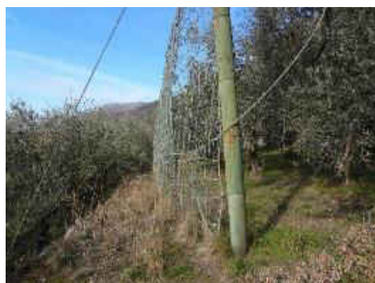
Figura 35 – Immagini delle reti, paramassi realizzate su tre linee, presenti a protezione dell'area oggetto di studio.
