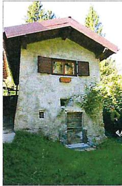
*Le casine ubicate su depositi di conoide al piede del fenomeno franoso non presentano lesioni di alcun genere; negli anni non sono stati effettuati lavori di rinforzo strutturale né di ristrutturazione, salvo interventi di manutenzione del tetto*
