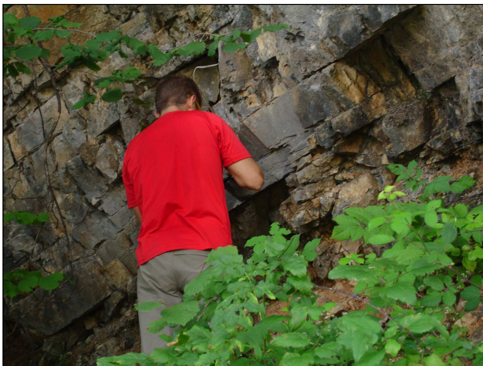
Immagine 5: Fase del rilievo geomeccanico
