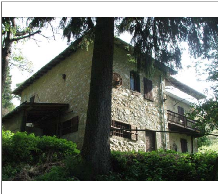
Corpo A fronte ovest e fronte nord (foto del 2006)
