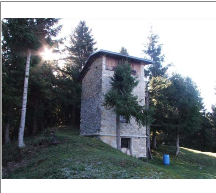
Corpo A vista da nord (foto del 2006)
