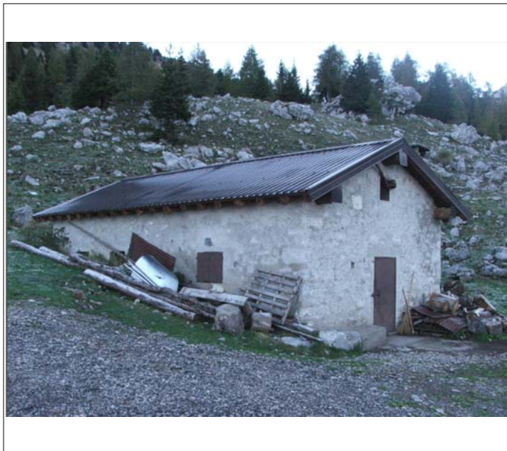
Corpo A vista da ovest (foto del 2006)
