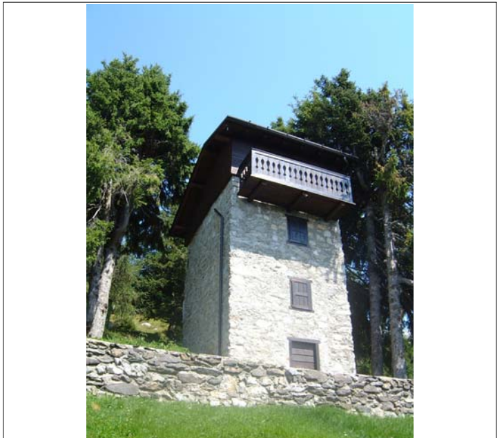
Corpo A fronte ovest e scorcio fronte nord
