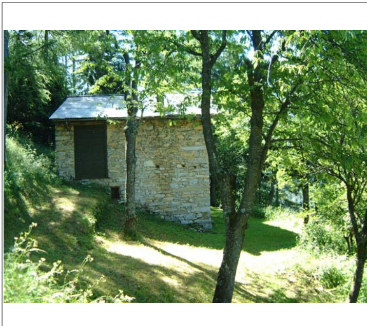
Corpo A fronte nord
