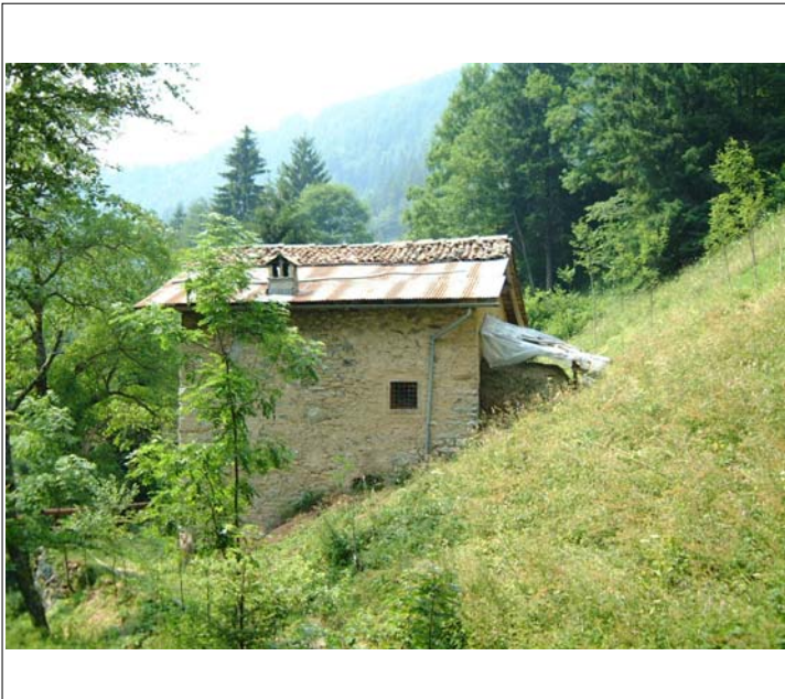
Corpo A fronte sud-est
