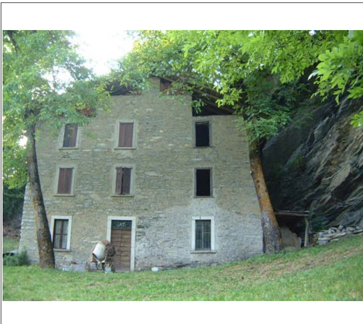
Corpo A fronte sud
