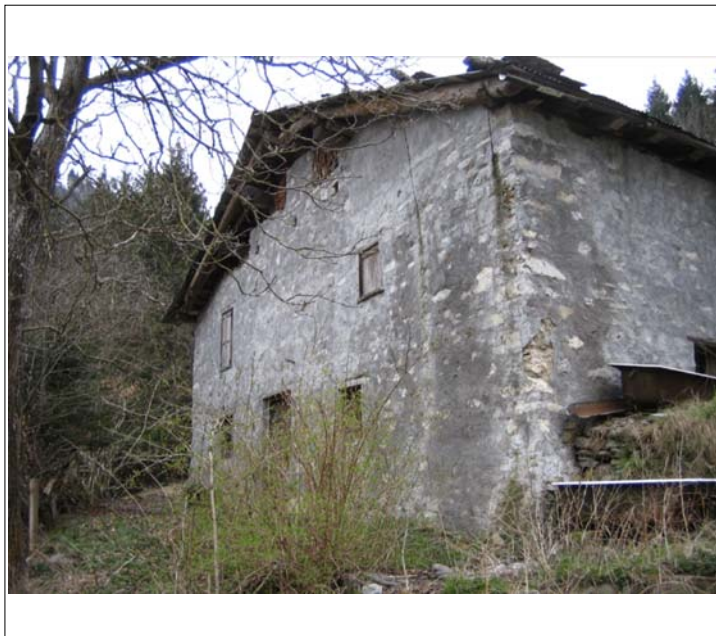
Corpo A vista da ovest foto del 2007
