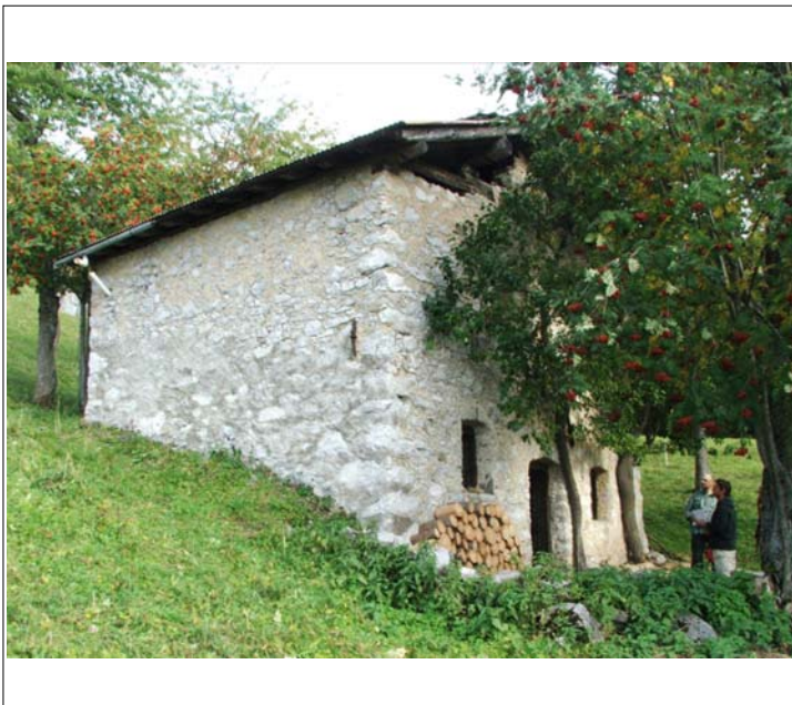
Corpo A vista da ovest (foto del 2006)
