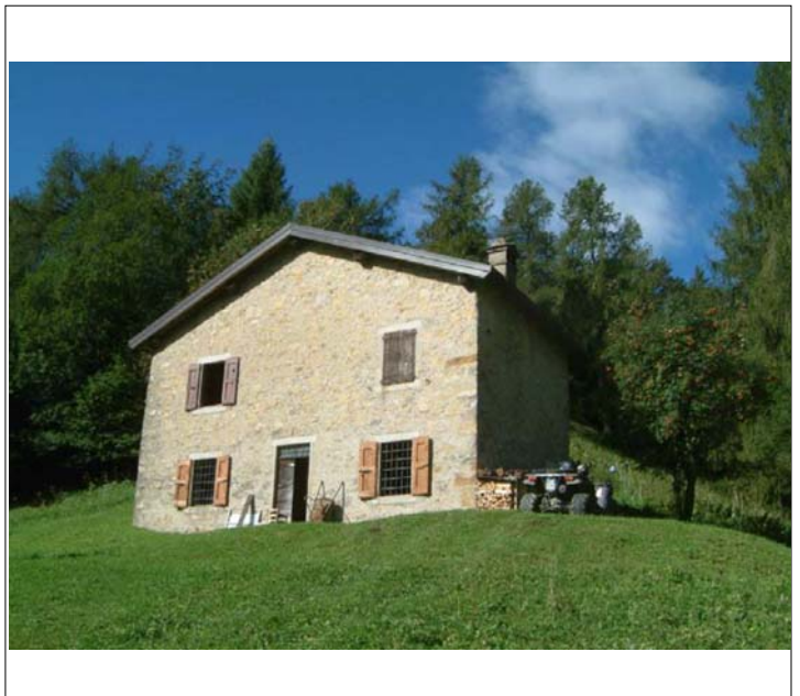
Corpo A fronte est (foto del 2006)
