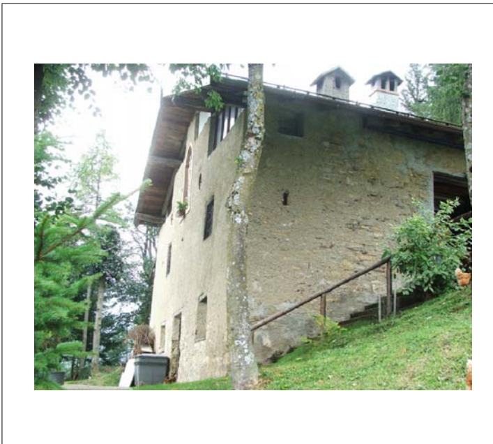
Corpo A fronte sud e scorcio fronte est (foto del 2006)
