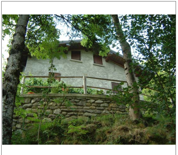
Corpo A fronte sud
