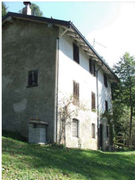
Corpo A vista da ovest (foto del 2006)
