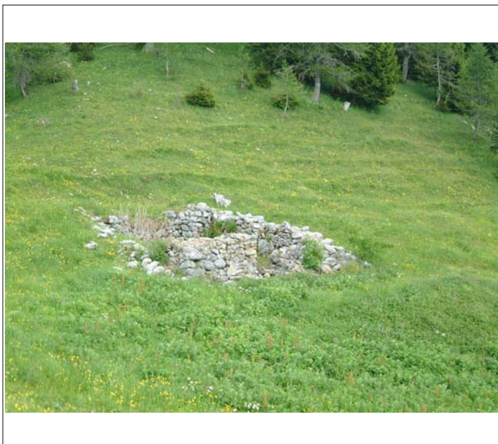
Corpo A vista da ovest
