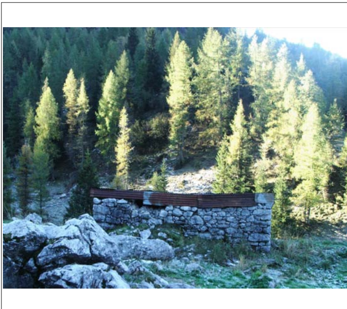
Corpo B vista da sud (foto del 2006)
