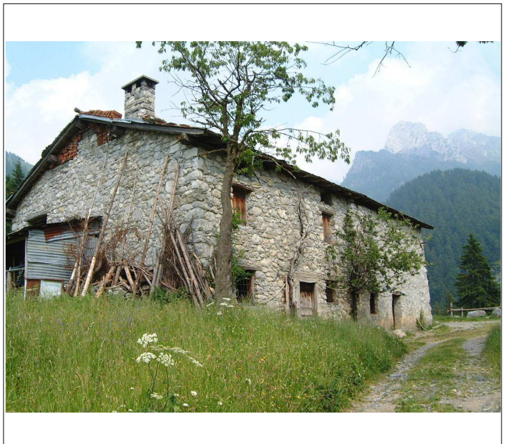
Corpo A fronte sud e ovest
