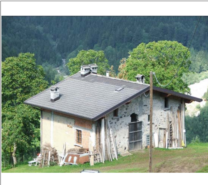
Corpo A vista da est (foto del 2006)
