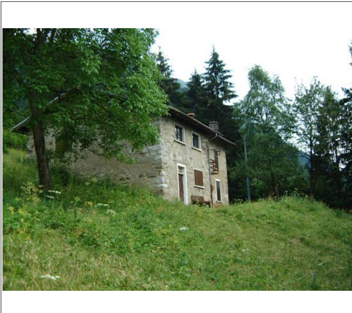
Corpo A fronte ovest e nord
