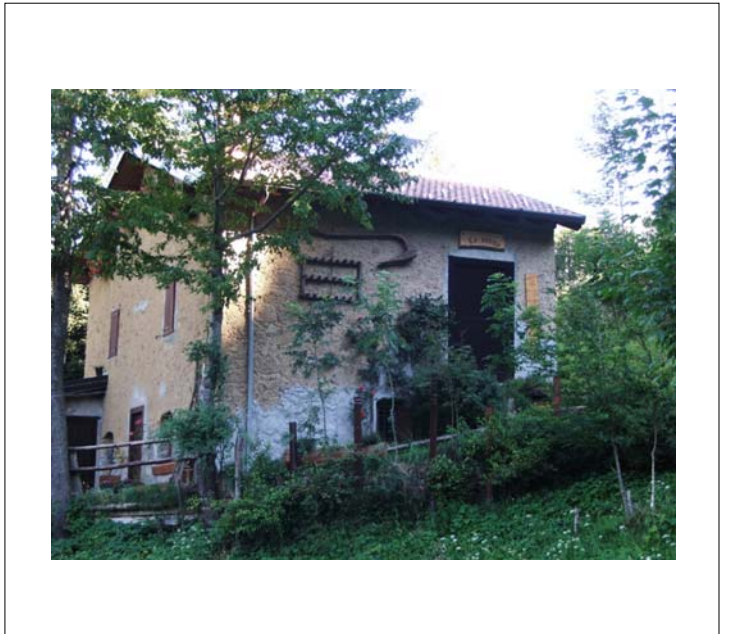
Corpo A fronte sud (foto del 2006)
