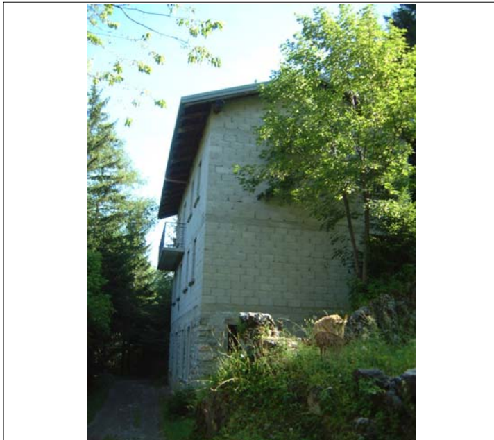
Corpo A vista da sud
