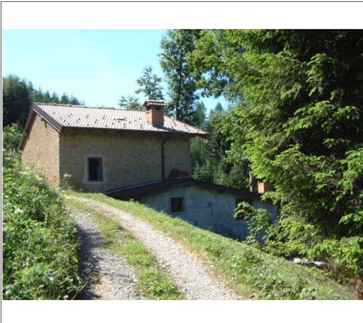
Corpo A e B fronte nord
