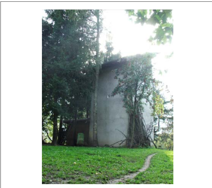
Corpo A vista da est (foto del 2006)
