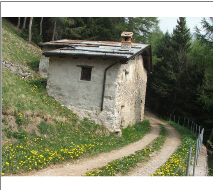
Corpo A vista da ovest (foto del 2006)
