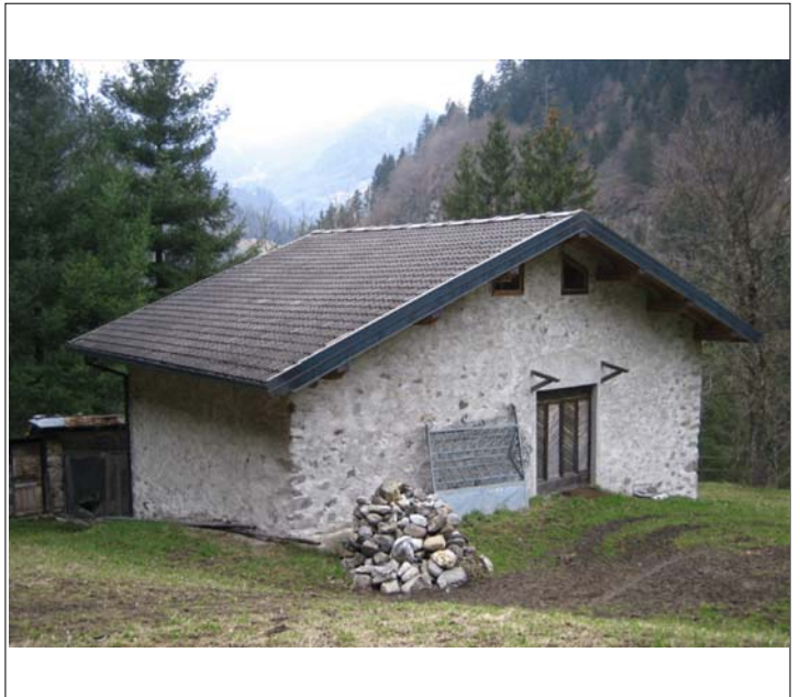
Corpo A vista da est (foto del 2007)
