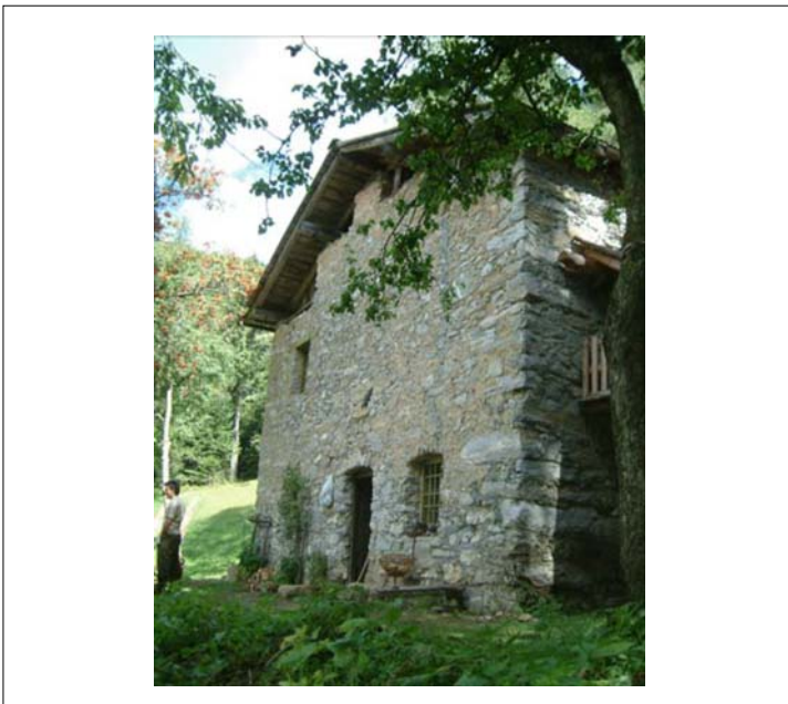
Corpo A fronte ovest (foto del 2006)
