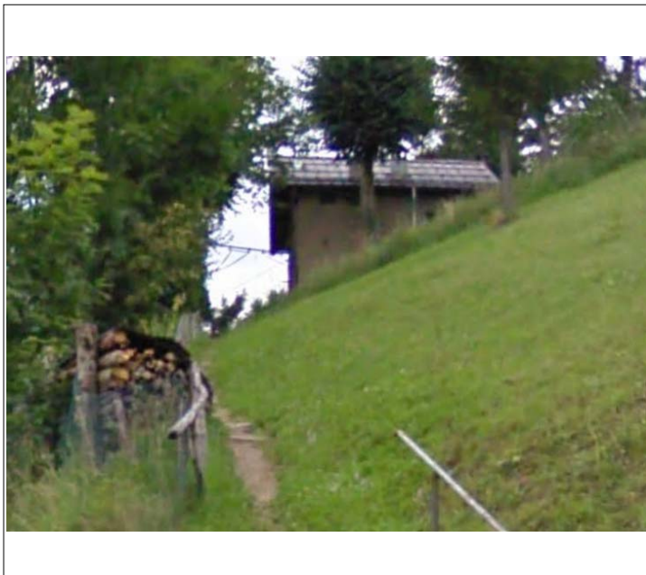
Corpo A fronte sud (foto del 2011)
