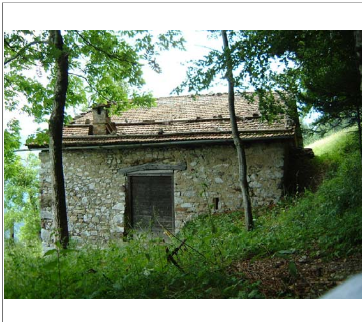
Corpo A fronte sud
