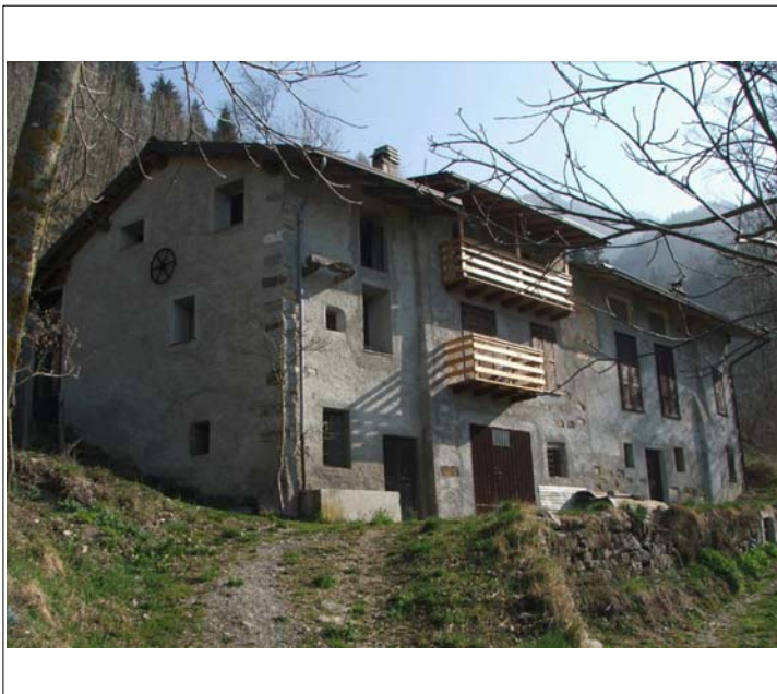
Corpo A fronte sud (foto del 2007)
