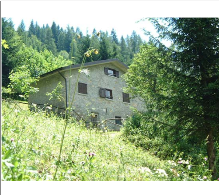
Corpo A fronte nord-ovest e nord-est
