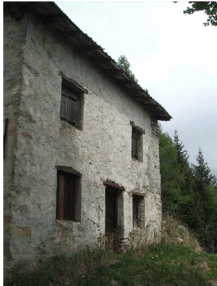
Corpo A fronte sud (foto del 2006)
