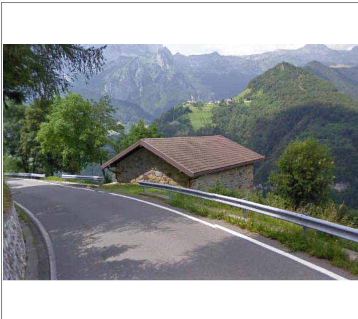
Corpo A fronte nord
