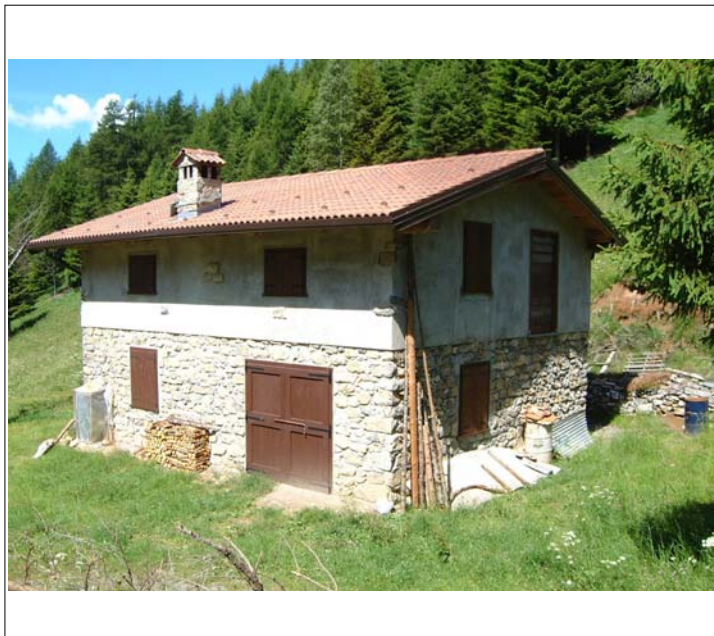
Corpo A fronte sud-est e nord-est
