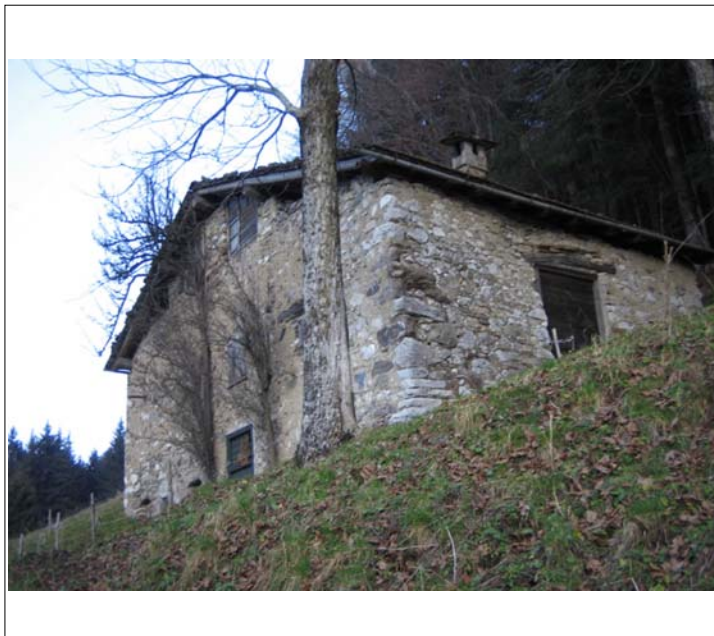
Corpo A vista da ovest (foto del 2006)
